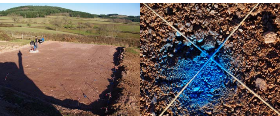
Marquage de l'implantation des pieux Krinner : fondations du prototype Armadillo Box 71
