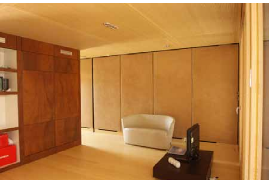
intérieur avec finition enduit terre
